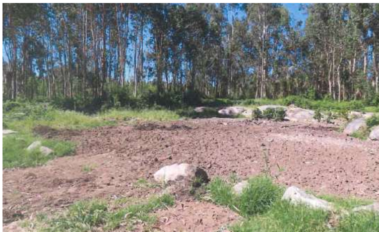
Despois da demolición
