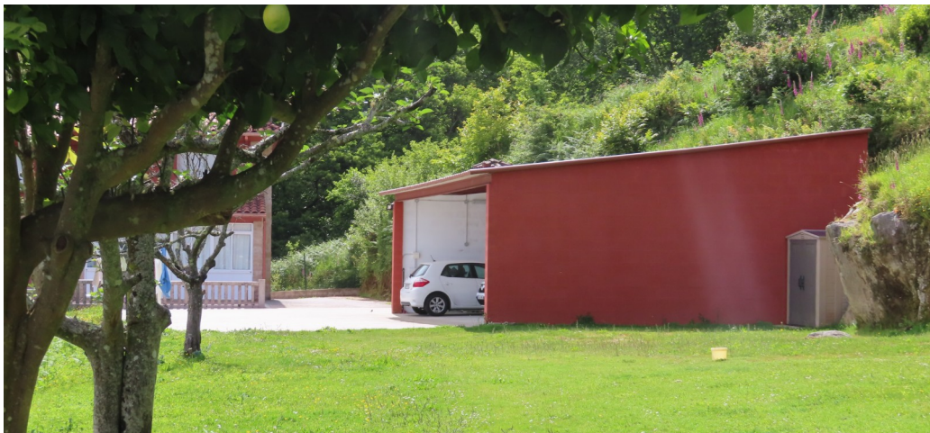
Despois da demolición
