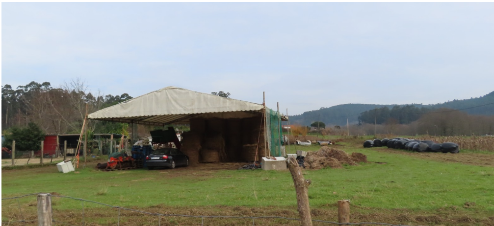
Antes da demolición
