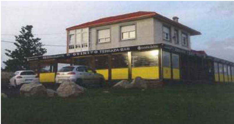
Antes da demolición
