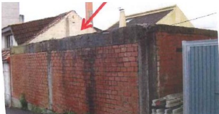
Despois da demolición
