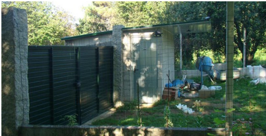
Despois da demolición
