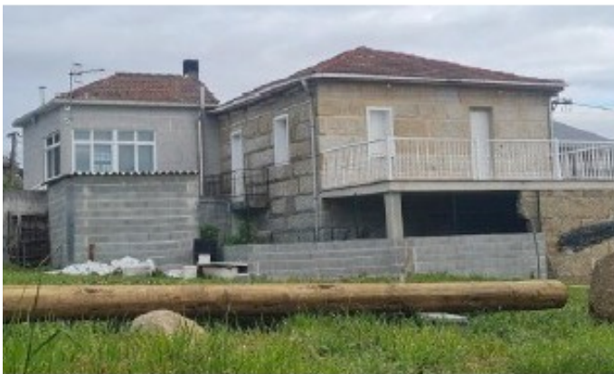
Antes da demolición
