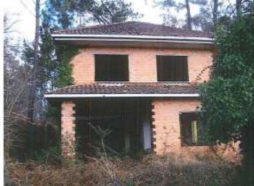
Antes da demolición
