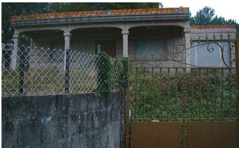
Antes da demolición
