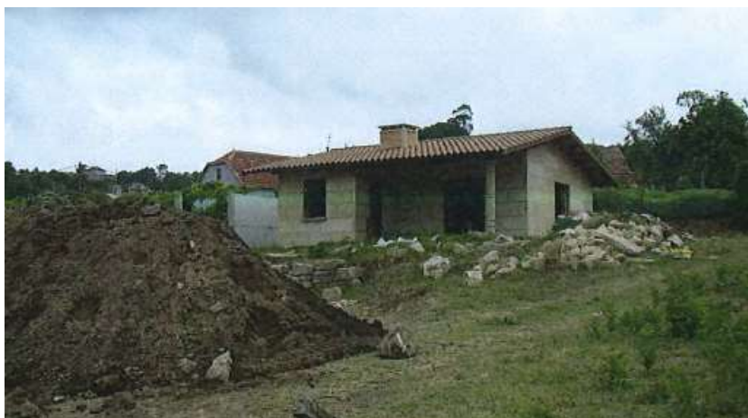
Antes da demolición
