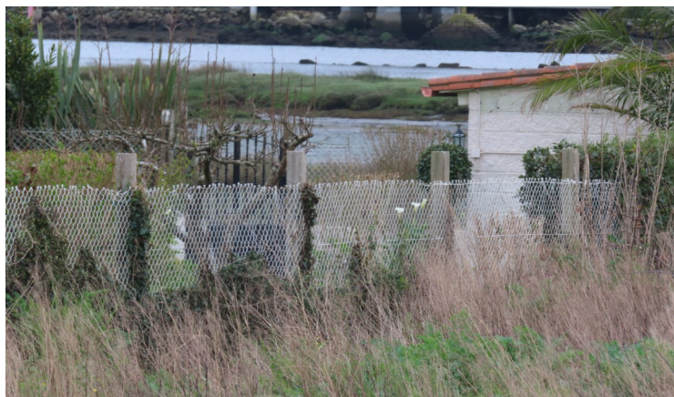
Despois da demolición
