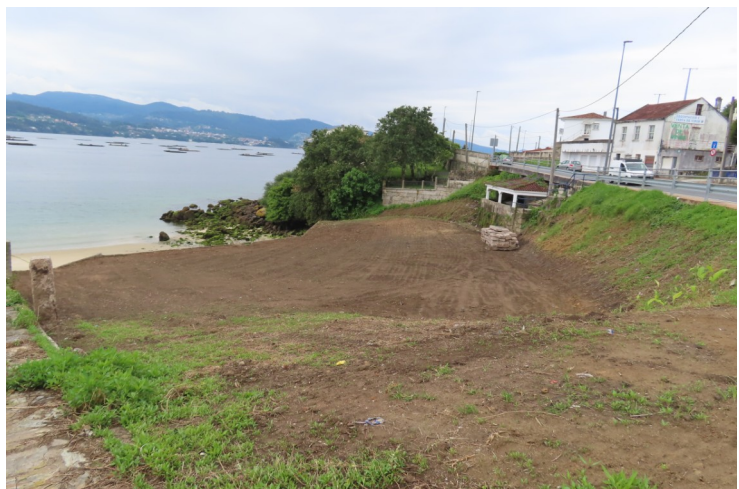
Despois da demolición
