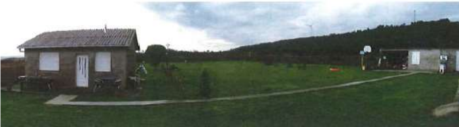
Antes da demolición
