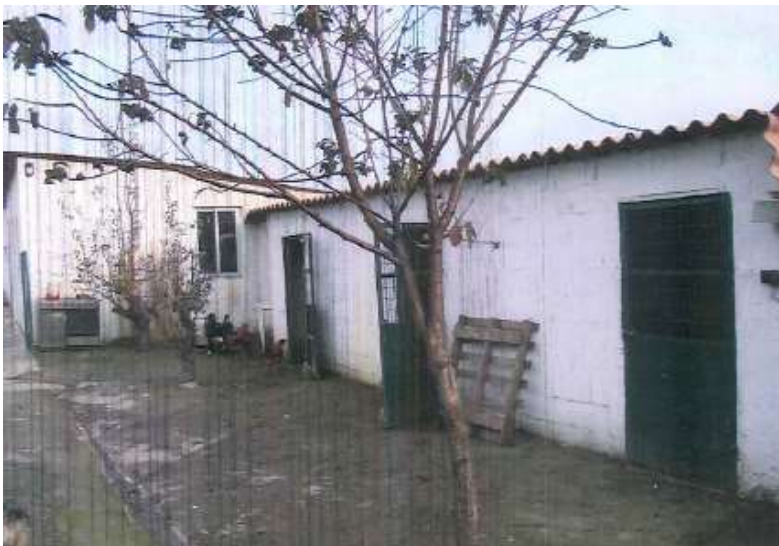
Antes da demolición
