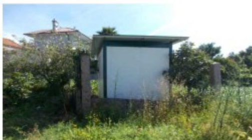
Antes da demolición
