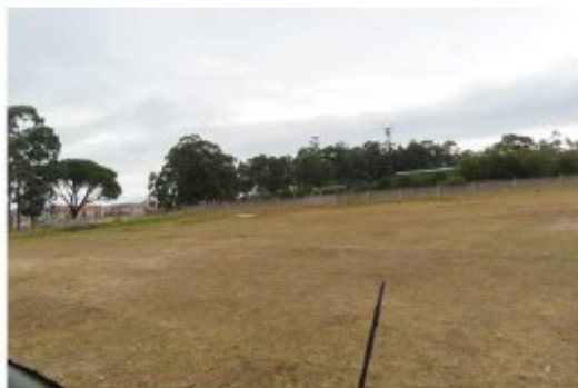
Despois da demolición
