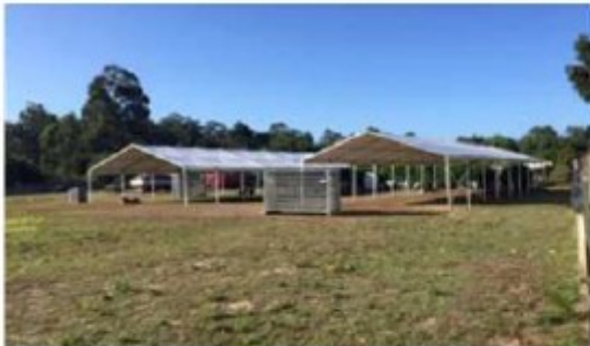
Antes da demolición
