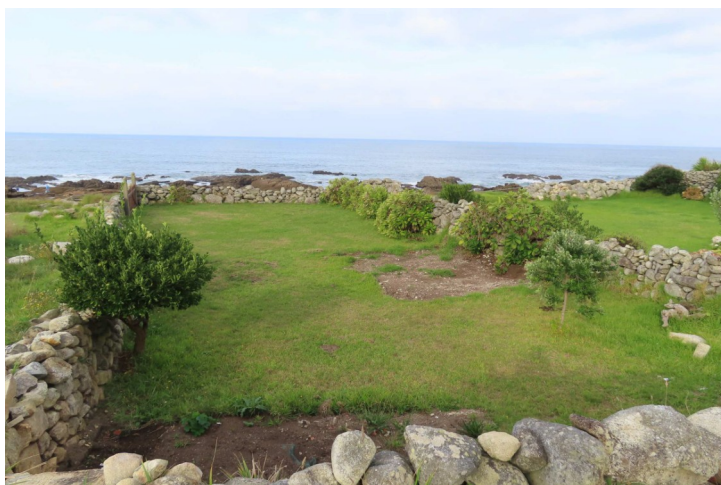
Despois da demolición
