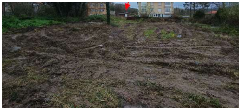
Despois da demolición
