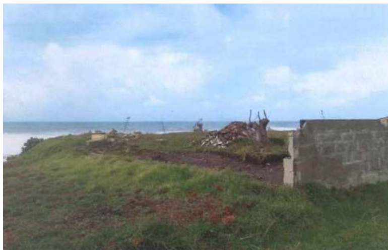
Despois da demolición
