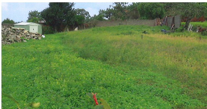
Despois da demolición
