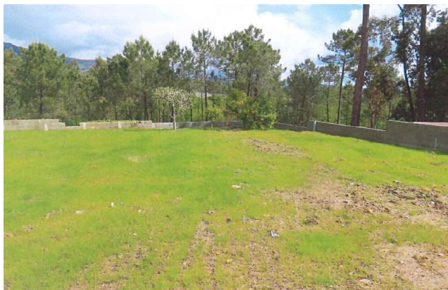
Despois da demolición
