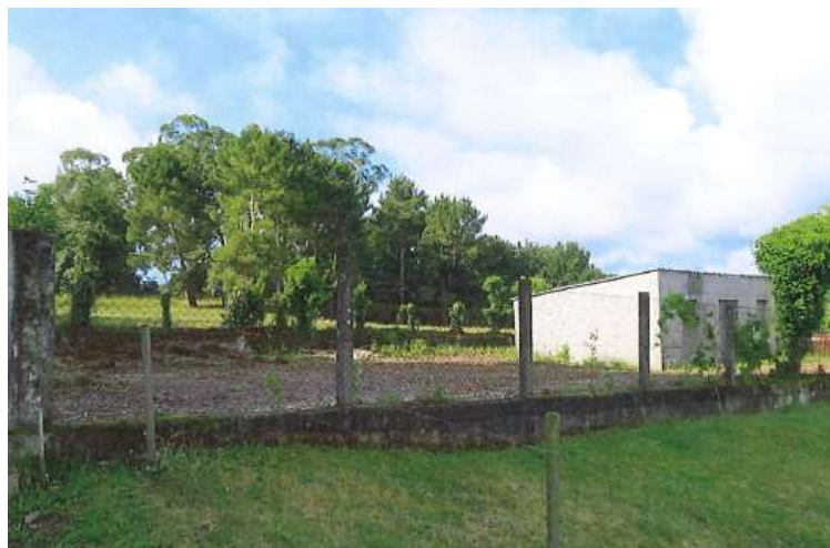
Despois da demolición
