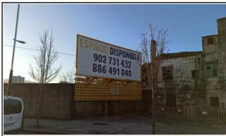
Antes da demolición
