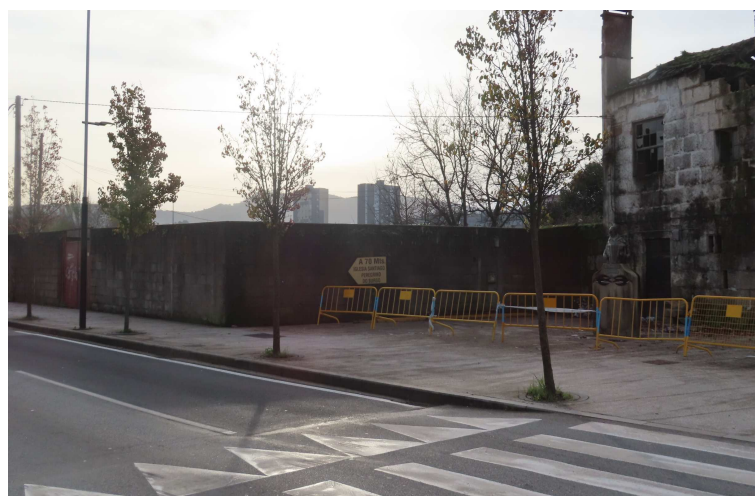
Despois da demolición
