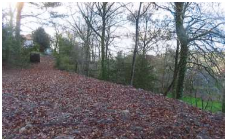
Despois da demolición
