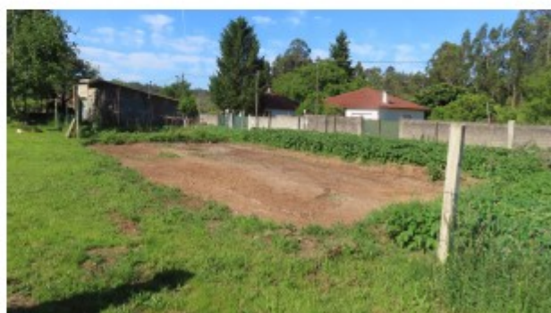
Despois da demolición
