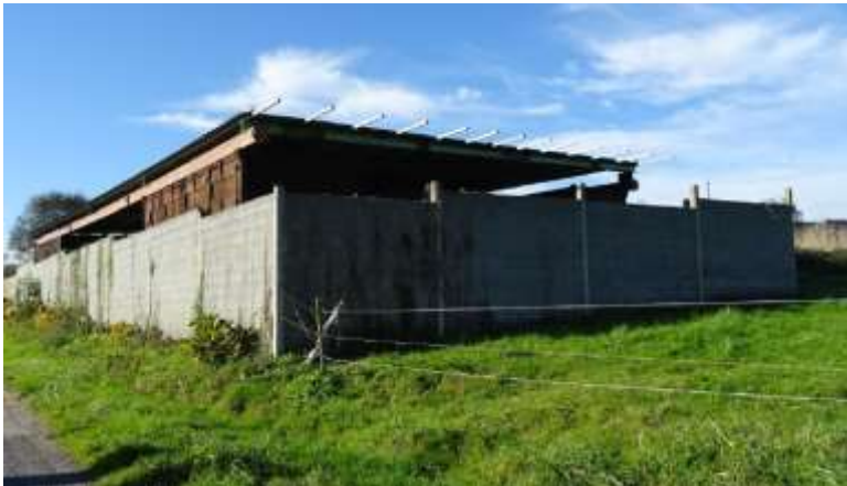
Antes da demolición
