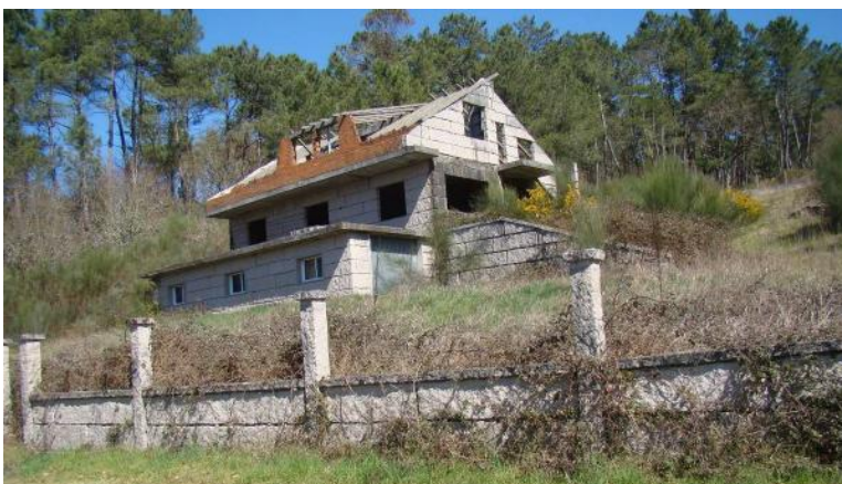
Antes da demolición
