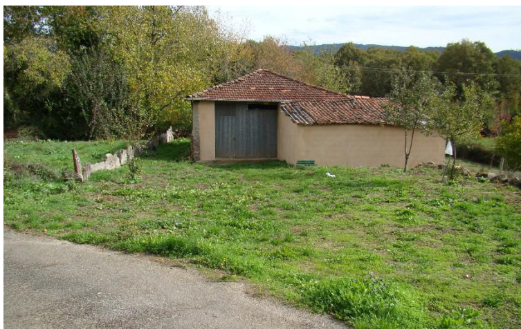
Despois da demolición
