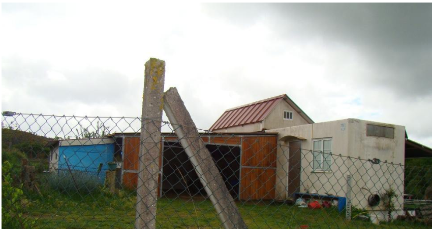
Antes da demolición
