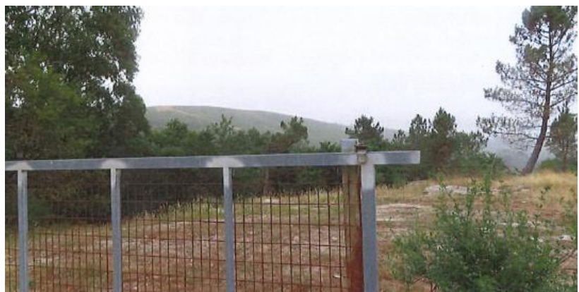
Despois da demolición
