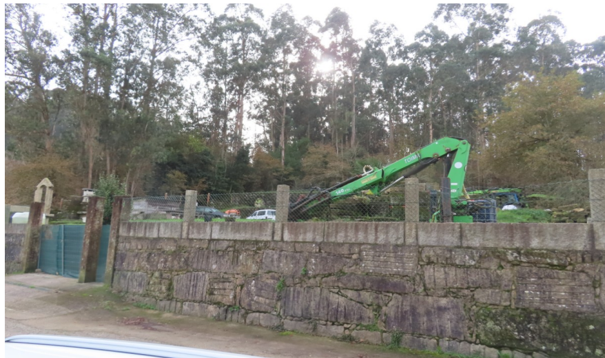
Despois da demolición
