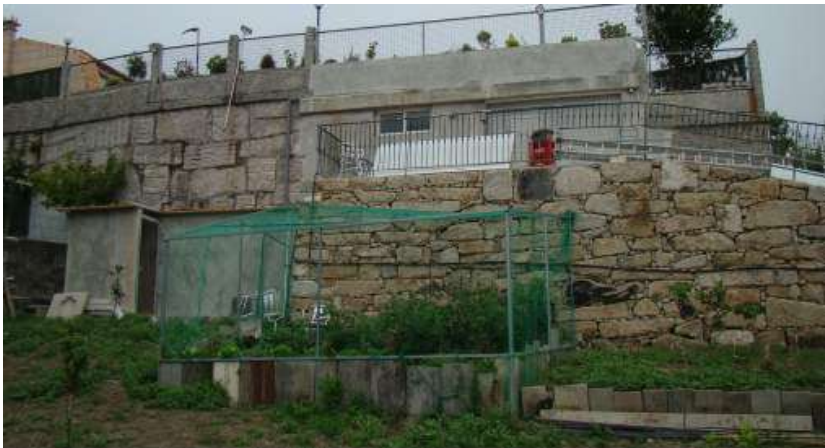
Antes da demolición
