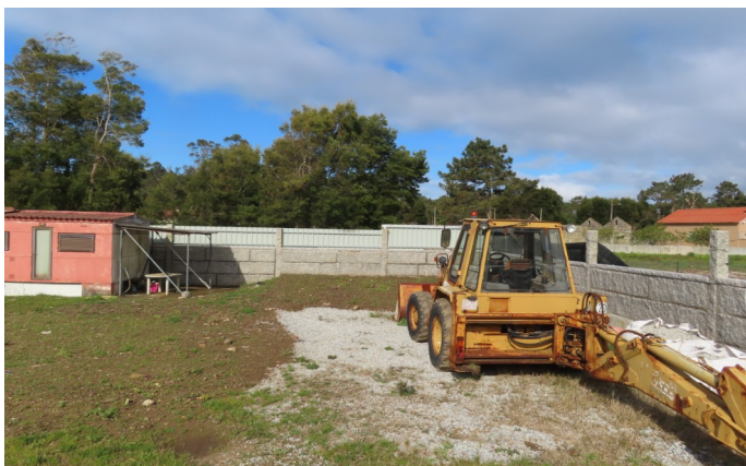
Despois da demolición
