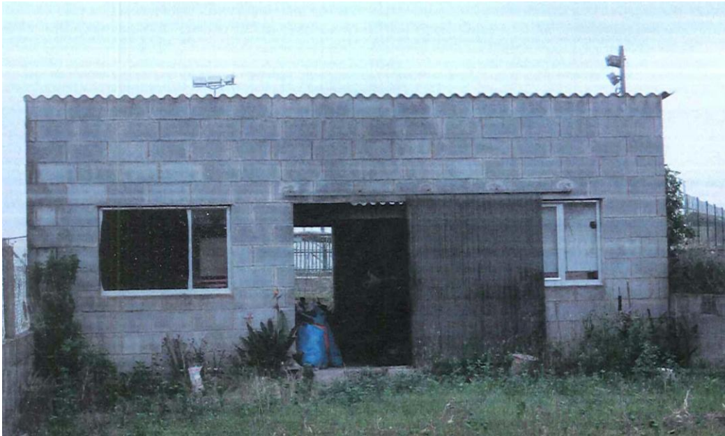
antes da demolición
