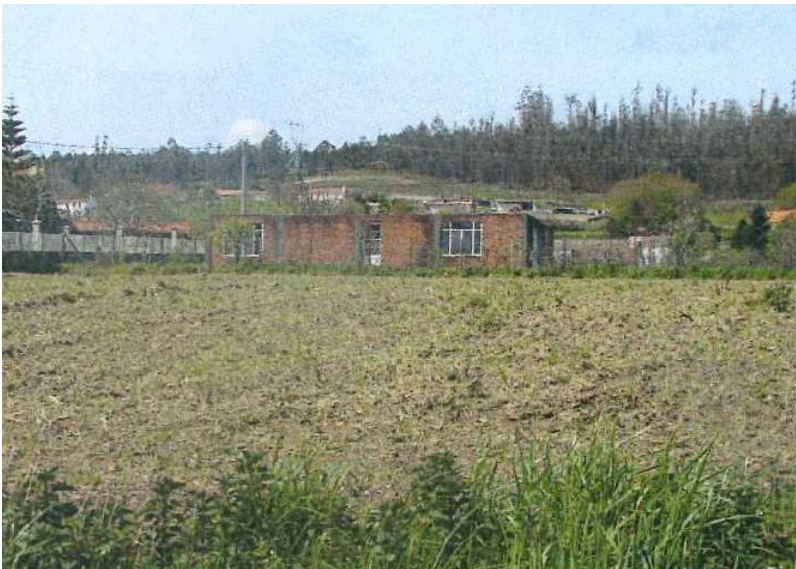
Antes da demolición
