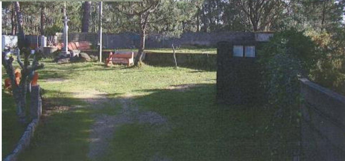
despois da demolición
