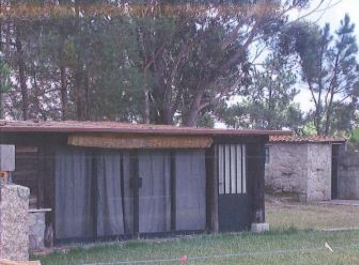
antes da demolición
