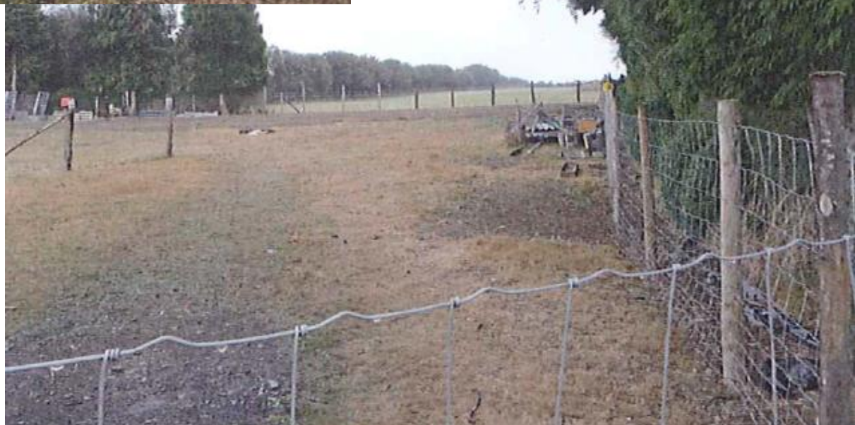
despois da demolición
