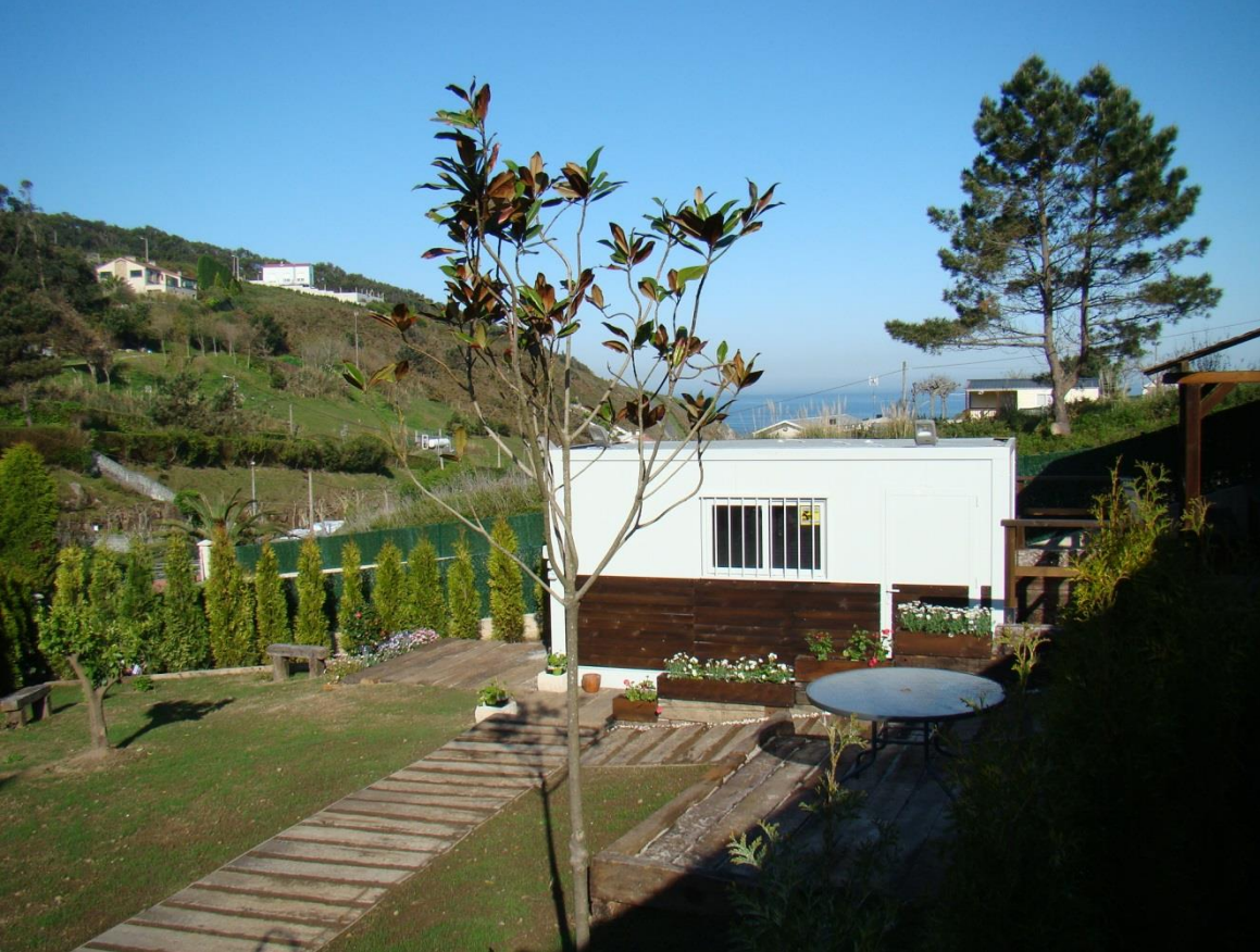
antes da demolición
