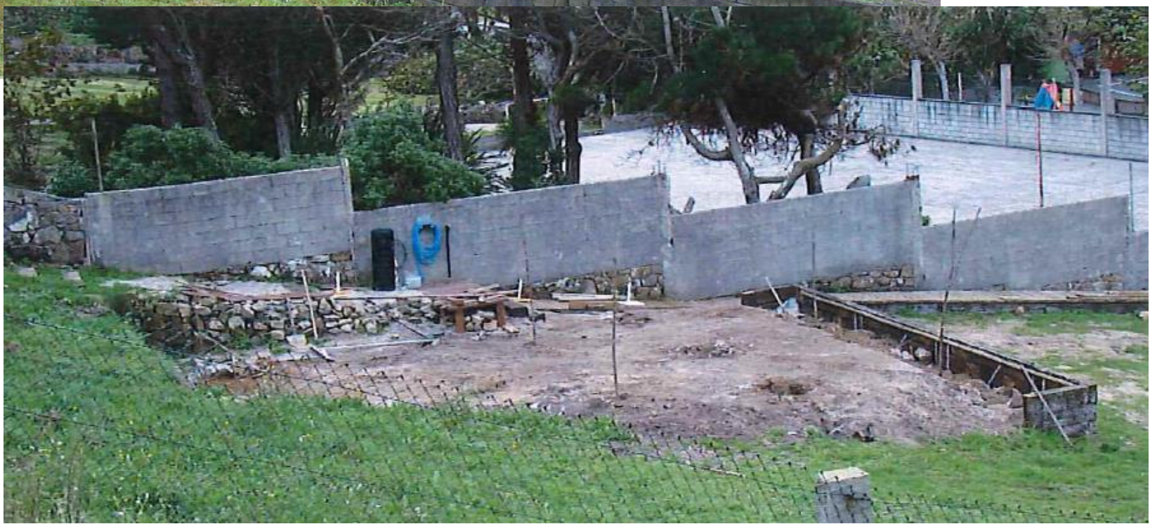
despois da demolição
