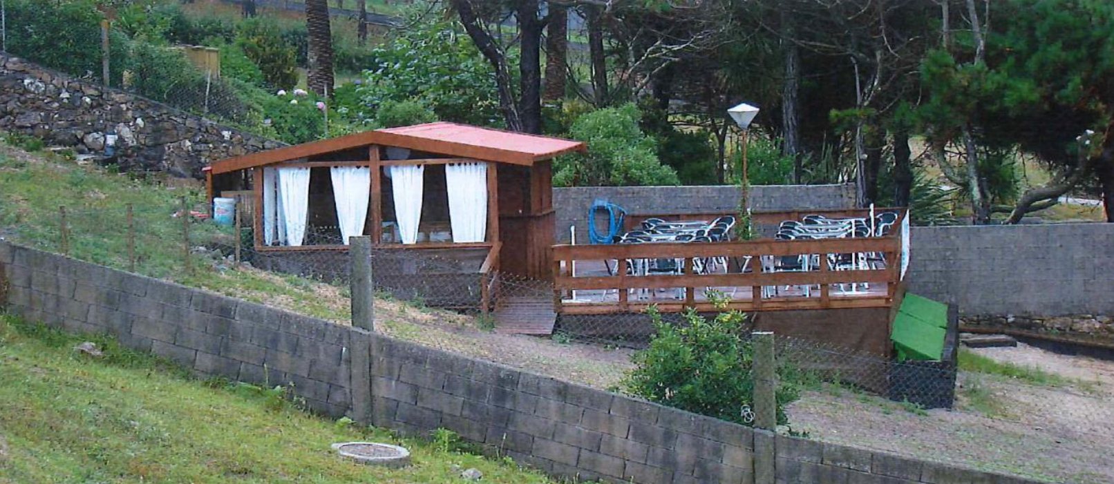
antes da demolição
