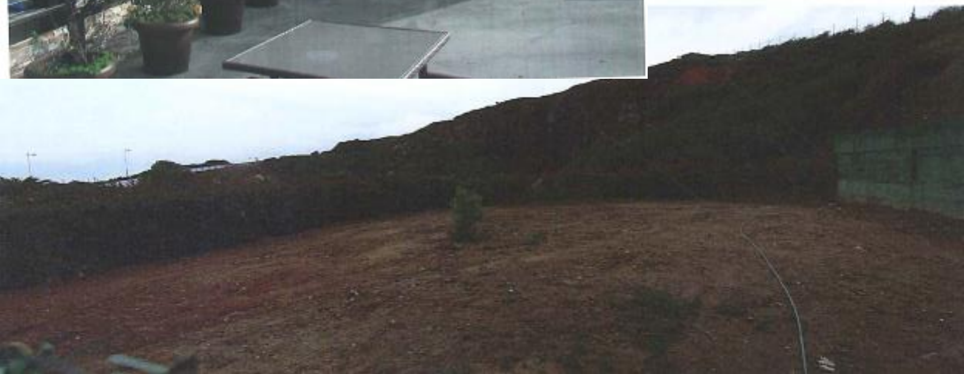
despois da demolición
