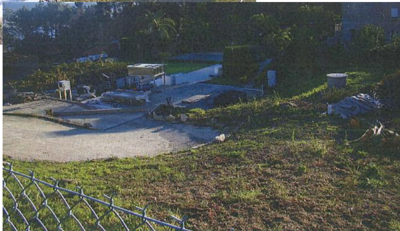
despois da demolición
