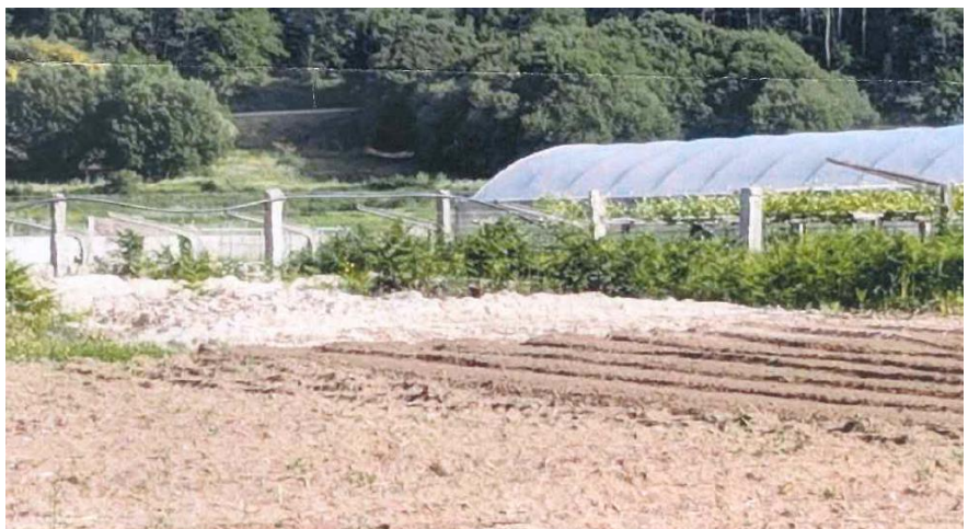
Despois da demolición
