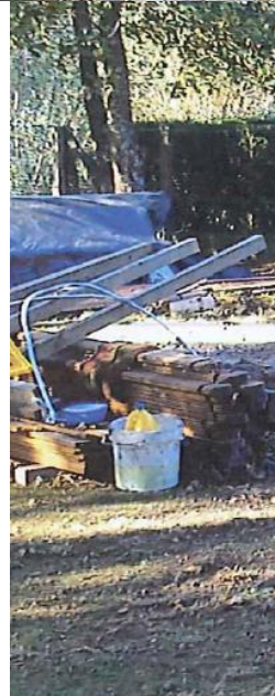
despois da demolición
