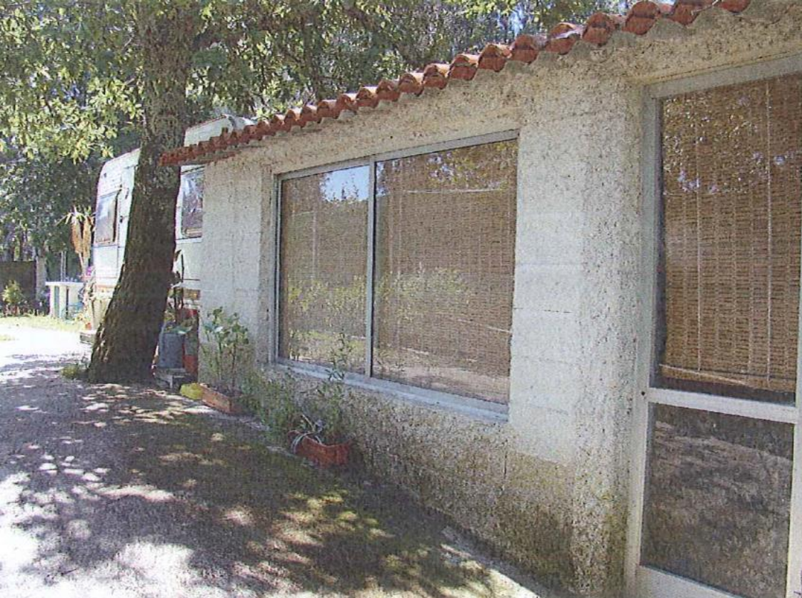
antes da demolición
