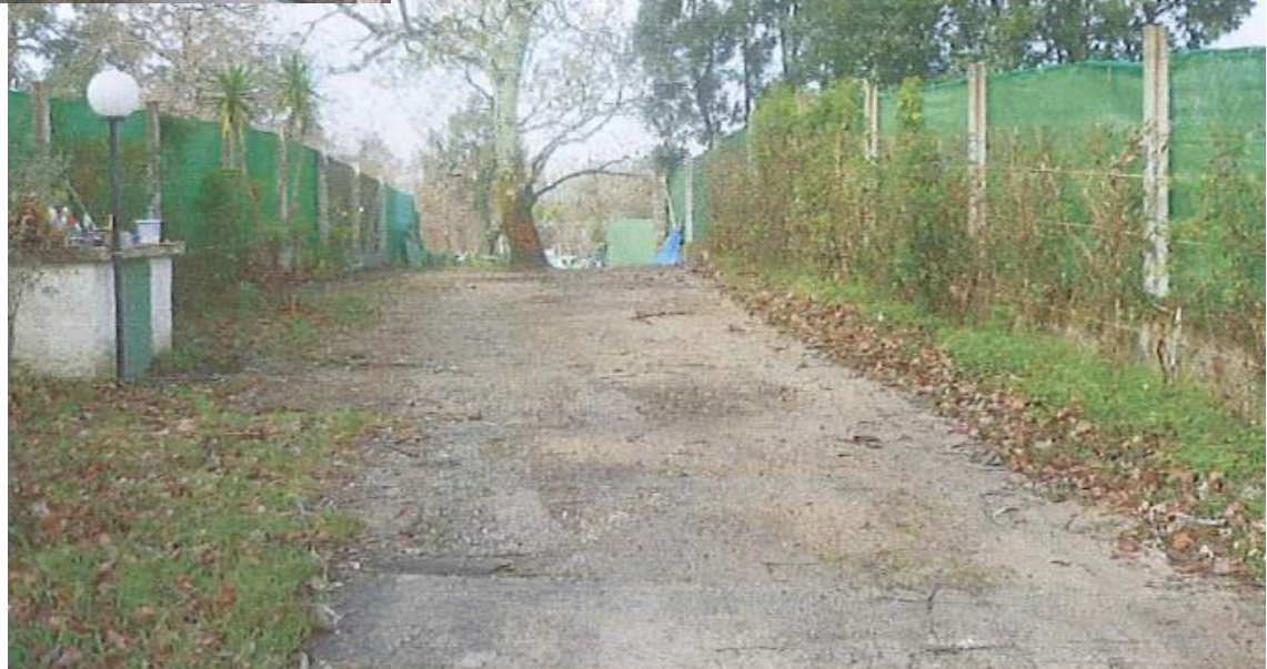
despois da demolición
