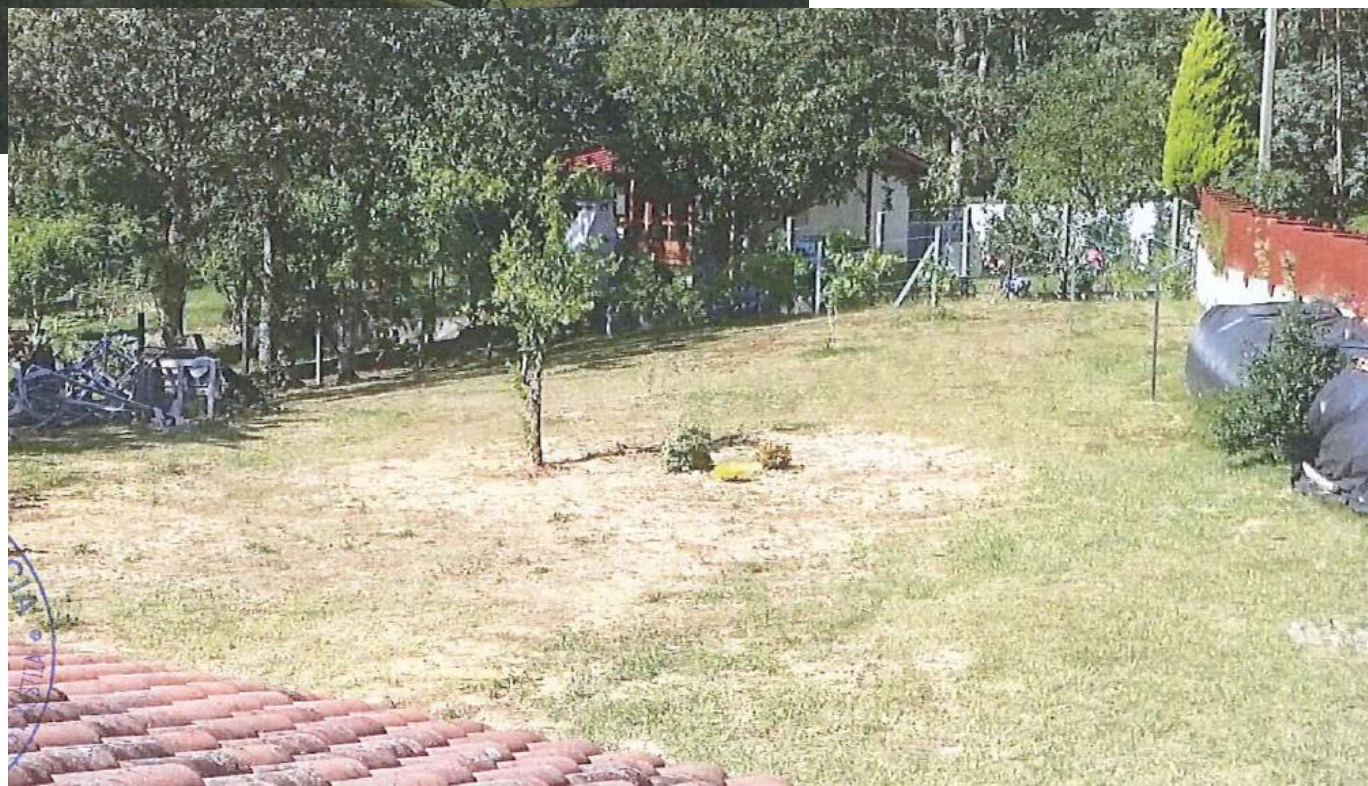
despois da demolición
