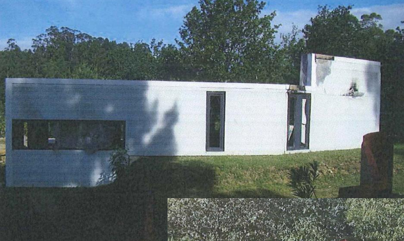
antes da demolición
