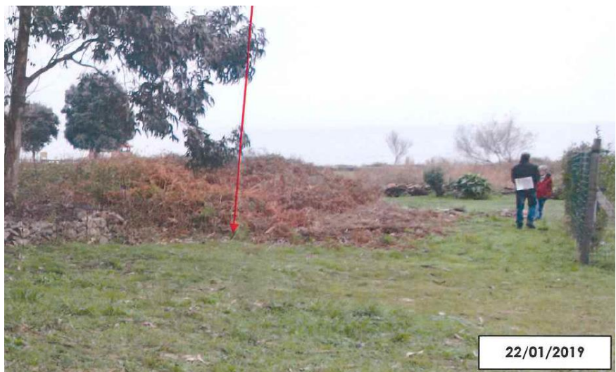
Despois da demolición
