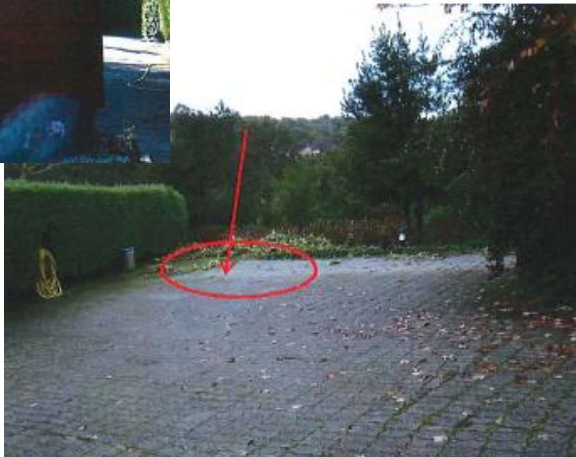
despois da demolición
