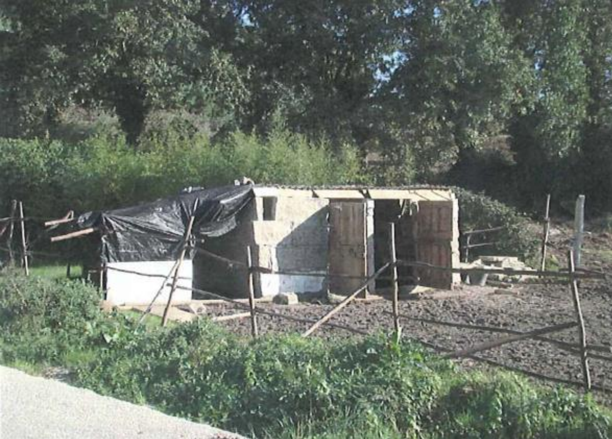
antes da demolición
