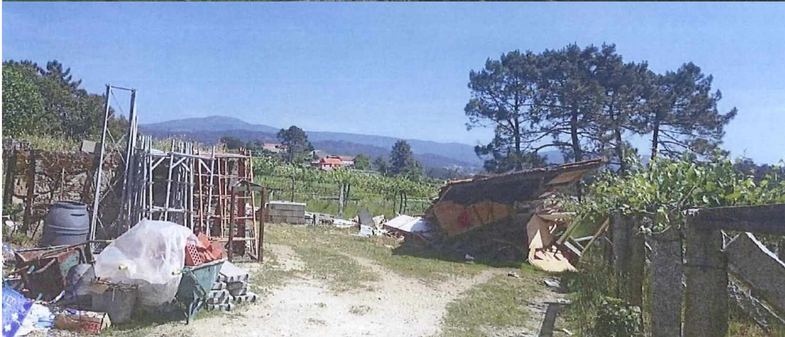
despois da demolição
