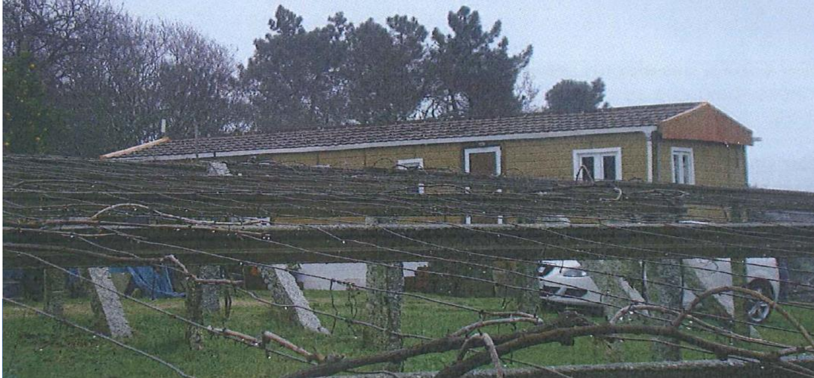
antes da demolição
