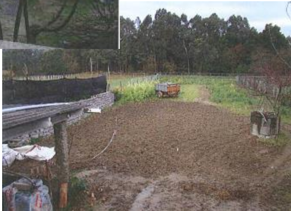
despois da demolición
